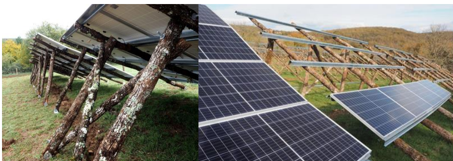
Figur 13. Eksempel på et bakkemontert solkraftverk i Frankrike hvor det er brukt lokalt trevirke i bærekonstruksjonen.
