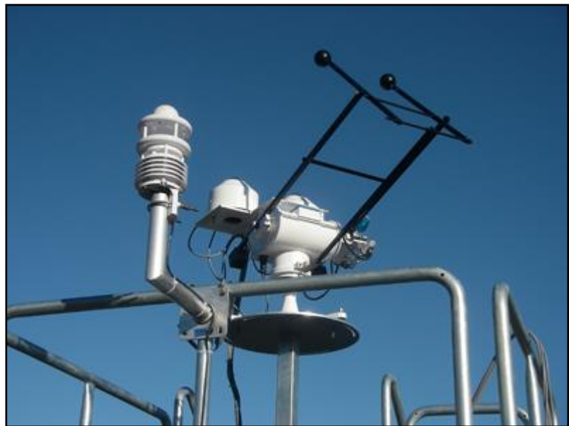
Figur 17. Målestasjon installert ved Glava Energy Center i Sverige. Foto: Multiconsult.
