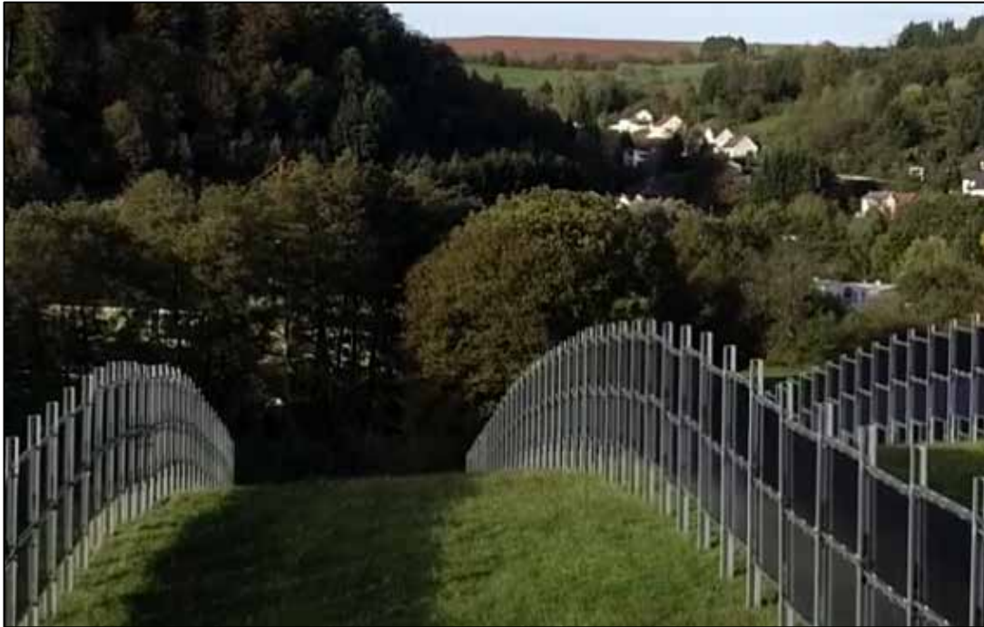
Tyske Next2Sun's løsning for vertikalmonterte paneler i nord-sørgående rekker. Her fra et anlegg sett fra sør.
